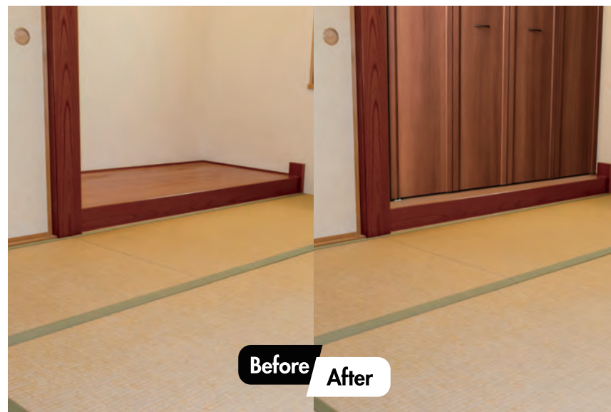
一間スペースの床の間に折れ戸を設置し、新たに収納スペースが誕生しました！
