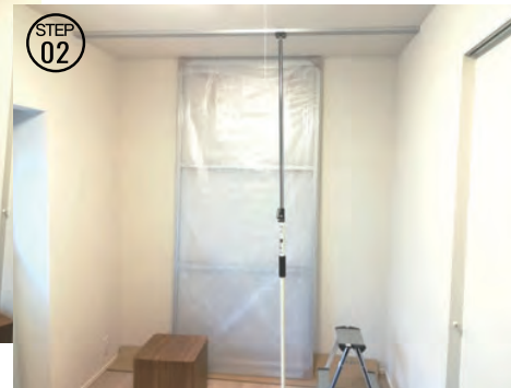
STEP 02 別売りの上レールと、 同封してお送りする下レールの取付け作業
